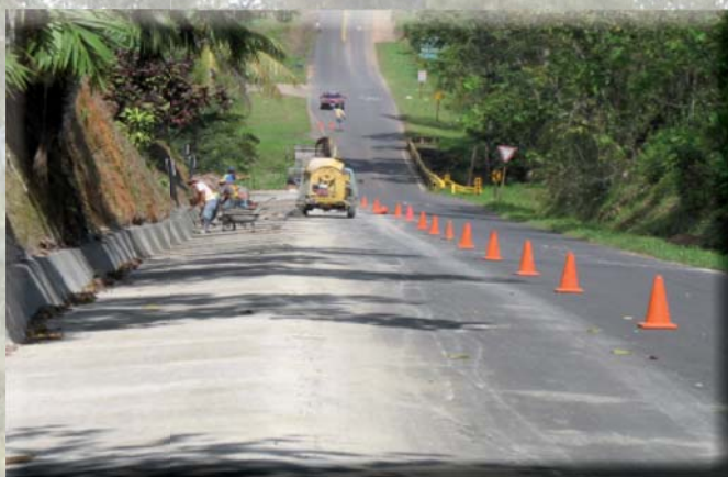
La Red Vial Nacional asfaltada, abarca 5.000km.
