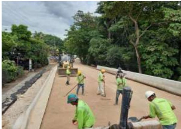
**Colocación de imprimación. Aproximación MI, Puente sobre el Río Esperanza**
