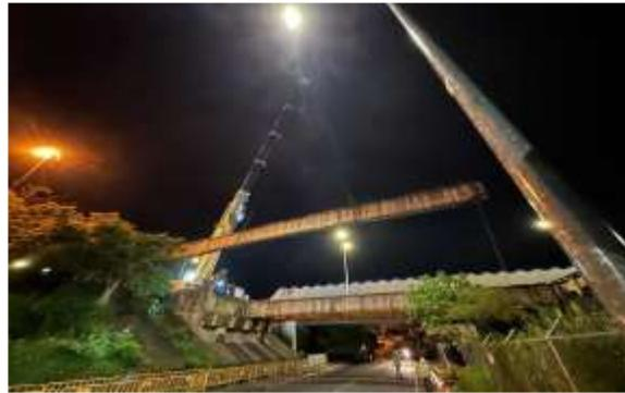
**Desmontaje nocturno de vigas AASHTO Vano 7, Proyecto Rehabilitación Puente Rio Virilla RN 32, mayo 2023**
