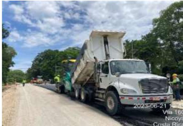
**Colocación de base. Aproximación MD, Puente sobre el Río Esperanza**
