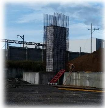
Construcción de zapata y columna para pilas del viaducto, proyecto Circunvalación Norte
