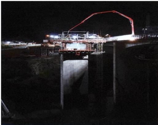
Colado de dovela C1 (entre pila 2 y el centro del puente, sector norte)
