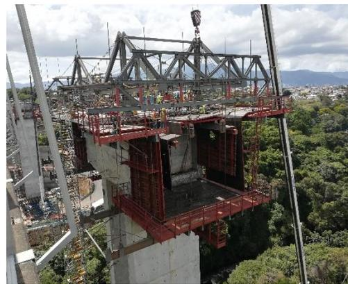
Colación de segundo carro deslizante para las dovelas entre pila 2 y bastión 2 (sector norte)
