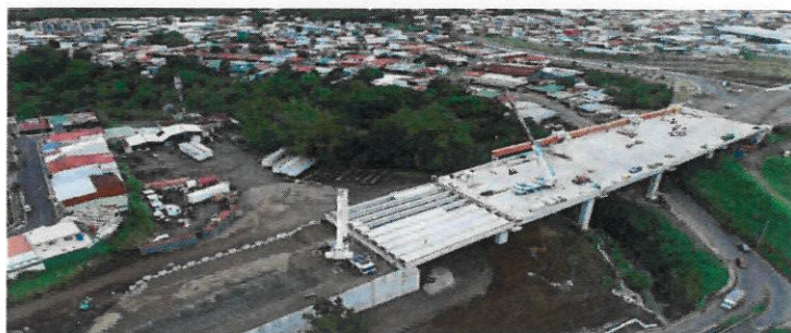
Avance construcción de puente Quebrada Rivera. Proyecto Circunvalación Norte.
