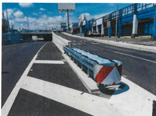
Rampas marginales Paso a Desnivel Guadalupe
