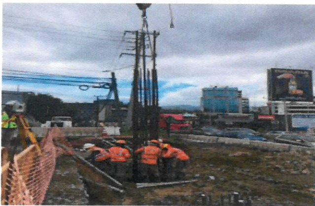
Colocación de acero de refuerzo y colado de pilotes
