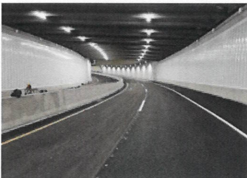
Prueba de iluminación Paso a Desnivel Guadalupe
