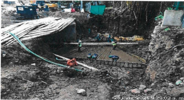
Construcción de alcantarilla de cuadro
