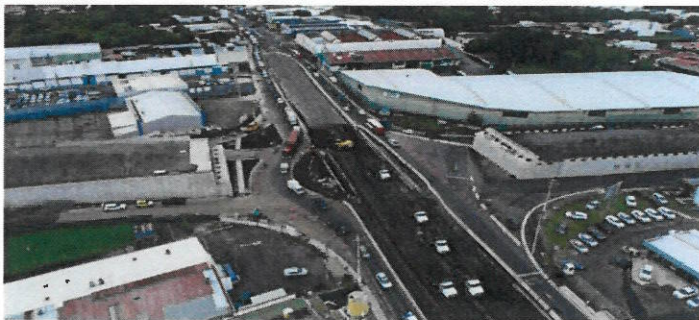
Vista aérea de rampas de Intersección en La Uruca, UF – 1. Proyecto Circunvalación Norte.
