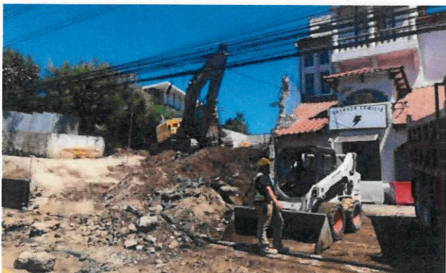
Trabajos de demolición.
