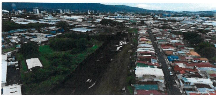
Limpieza de área para inicio de construcción de UF – 5. Proyecto Circunvalación Norte.
