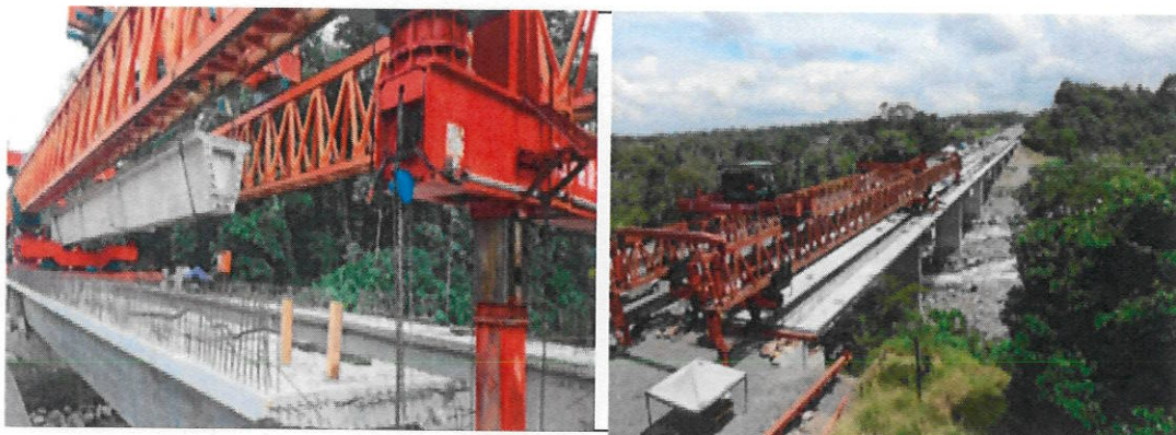
Ruta Nacional No.32, Puentes sobre el Río Blanco y Toro Amarillo
