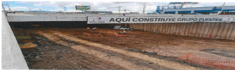
Excavación paso deprimido
