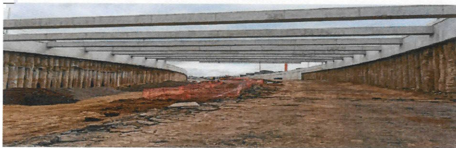
Excavación paso deprimido
