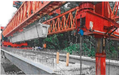
Puente Río Blanco
