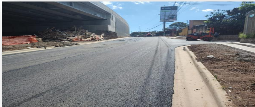
Fotografías de trabajos realizados en Marginales y otros Hatillo 4:
