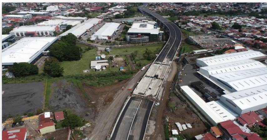
Conformación de marginales y finalizado del viaducto. Proyecto Circunvalación Norte.
