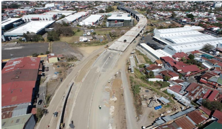
Finalización de colado de losas del viaducto en UF-5
