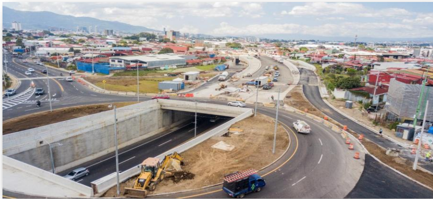
Trabajos de conformación de marginales, rellenos y compactación de material.
