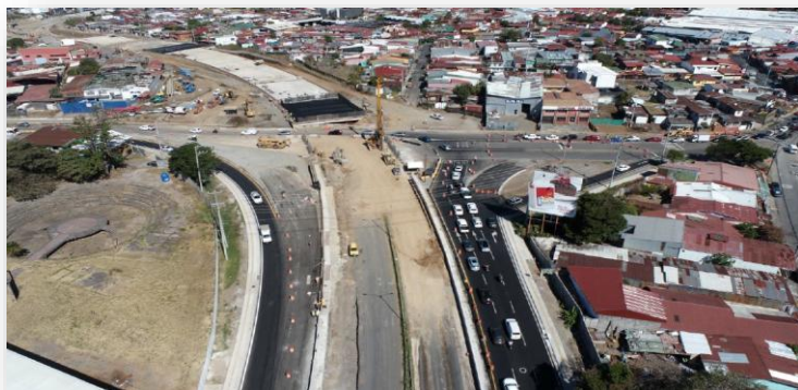
Construcción de Pilotes Rotonda, curado y colado de tableros del paso inferior en UF-5 Proyecto Circunvalación Norte.
