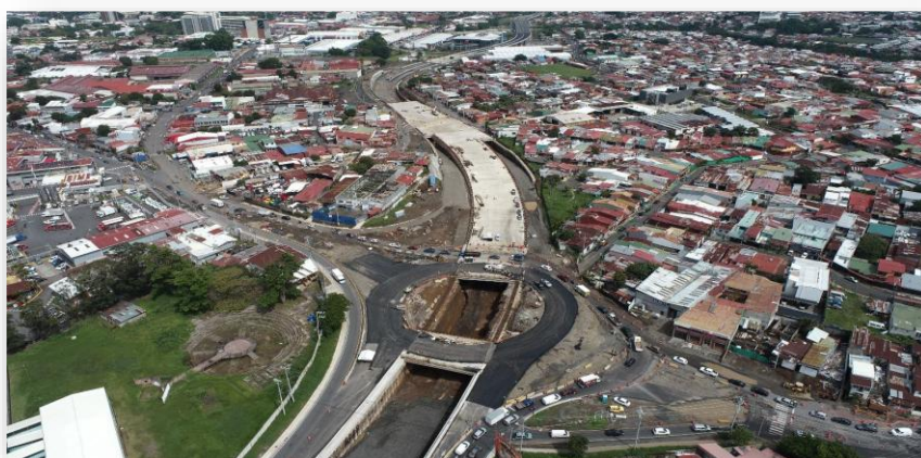
Trabajos en el sector de la rotonda. Circunvalación Norte.
