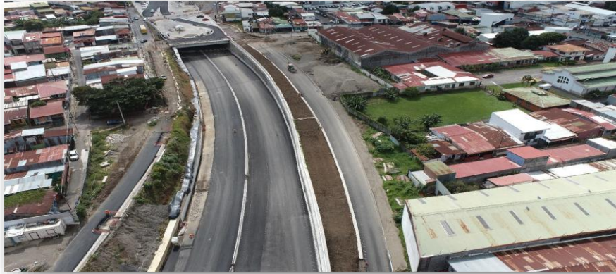
Trabajos asfaltado y colocación barrera contención vehicular, tronco principal.
