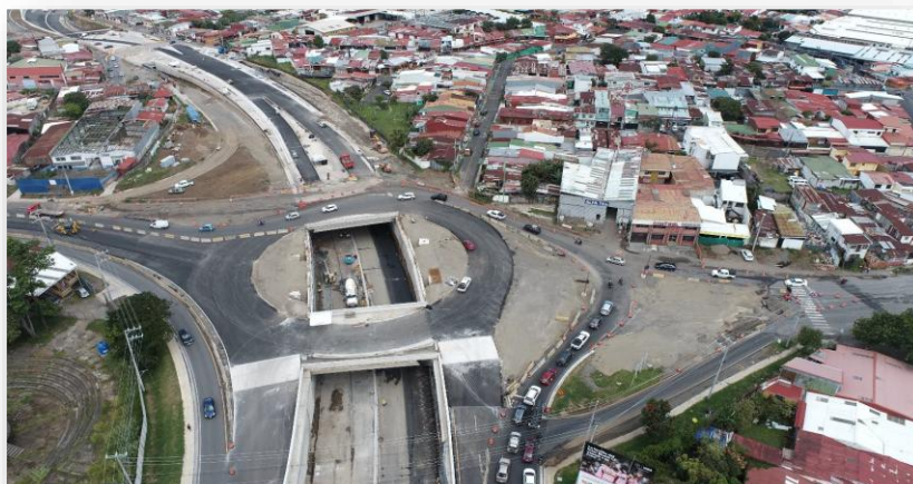
Conformación de marginales y finalizado del viaducto.
