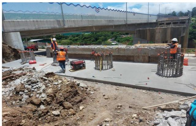
**Colado de concreto reforzamiento pila 2. Proyecto Rehabilitación Puente Rio Virilla RN 32, agosto 2023.**
