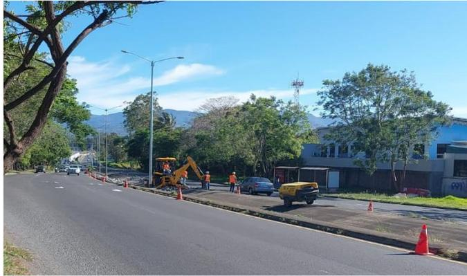
**Excavación para ampliación de cimentación Pilas 3 y 4. Proyecto Rehabilitación Puente Rio Virilla RN 32, junio 2023.**
