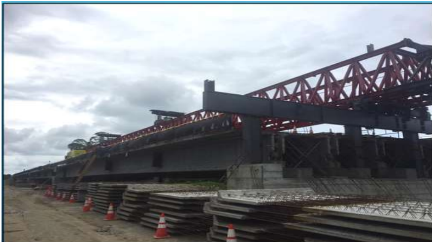
Avance en la construcción de los primeros cuatro vanos del puente. Vista Sur-Norte. Fuente: UNOPS.
