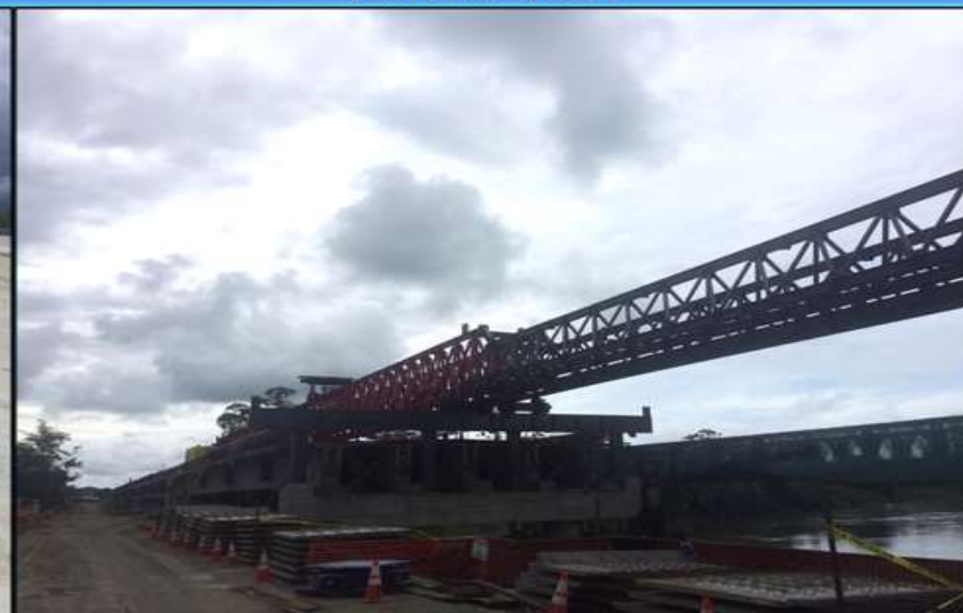
Posicionamiento de lanzavigas sobre el vano 4 para la instalación de las vigas del vano 5. Fuente: UNOPS.
