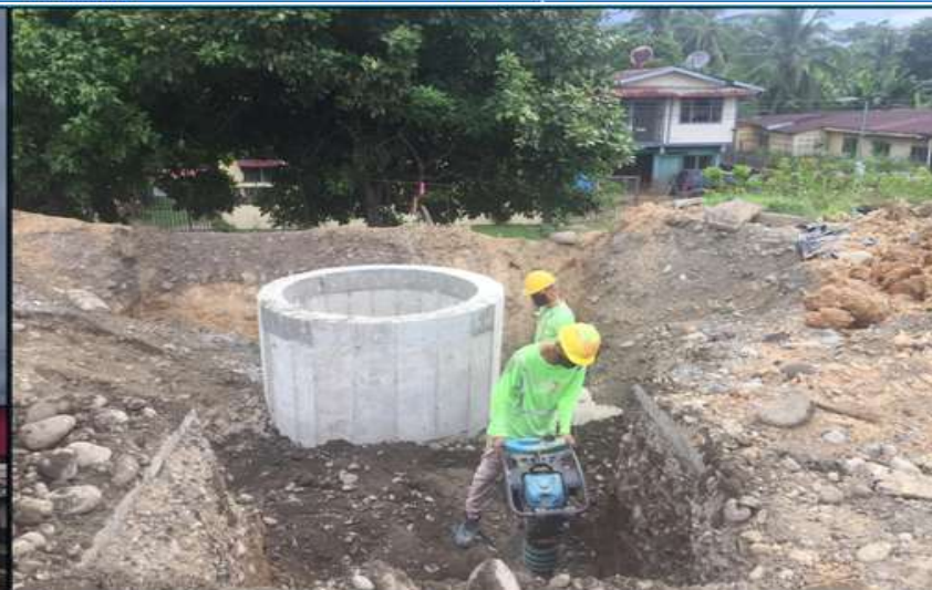
Avance en la construcción de drenajes menores del lado Costa Rica. Fuente: UNOPS.
