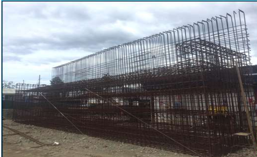
Avance en confección de armadura del Bastión 2. Fuente: UNOPS.
