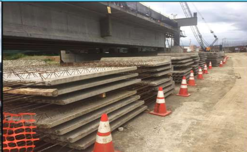
Prelosas del vano 5 transportadas al sitio de obra. Fuente: UNOPS.
