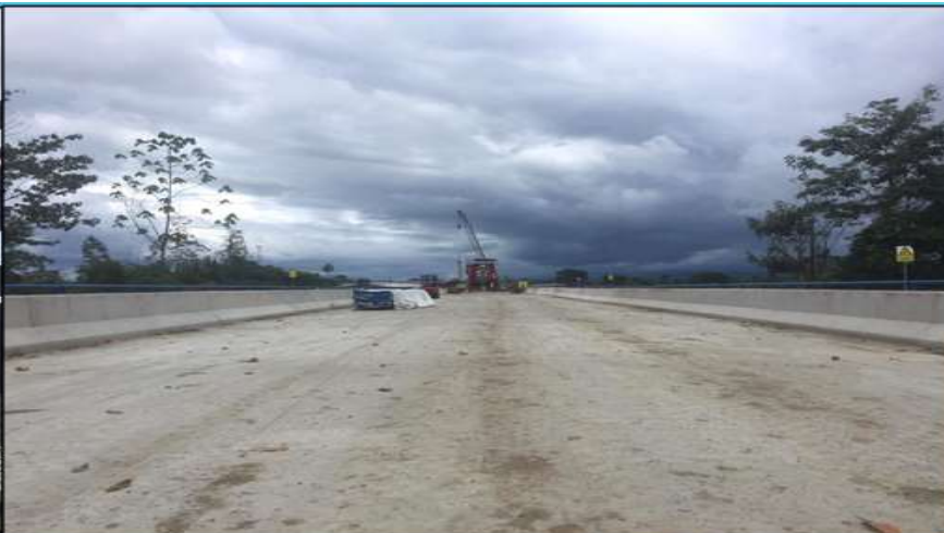
Losa estructural finalizada de los vanos 1, 2, 3 y 4. Vista Norte-Sur. Fuente: UNOPS
