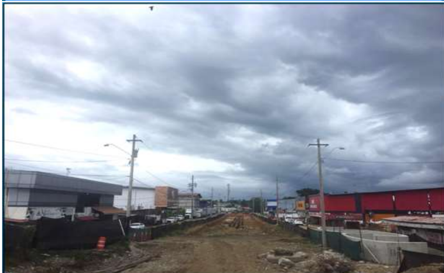
Finalización de reubicación de tendido eléctrico en Guabito y avance en excavación para muro. Fuente: UNOPS.
