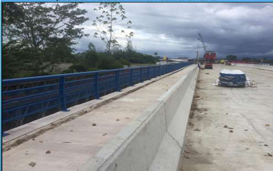
Avance de barreras New Jersey y barandas metálicas MZ en vanos 1, 2 y 3. Fuente: UNOPS.
