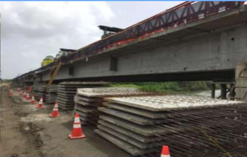
Losas prefabricadas Filiaran del vano 5. Vista Sur – Norte. Fuente: UNOPS.
