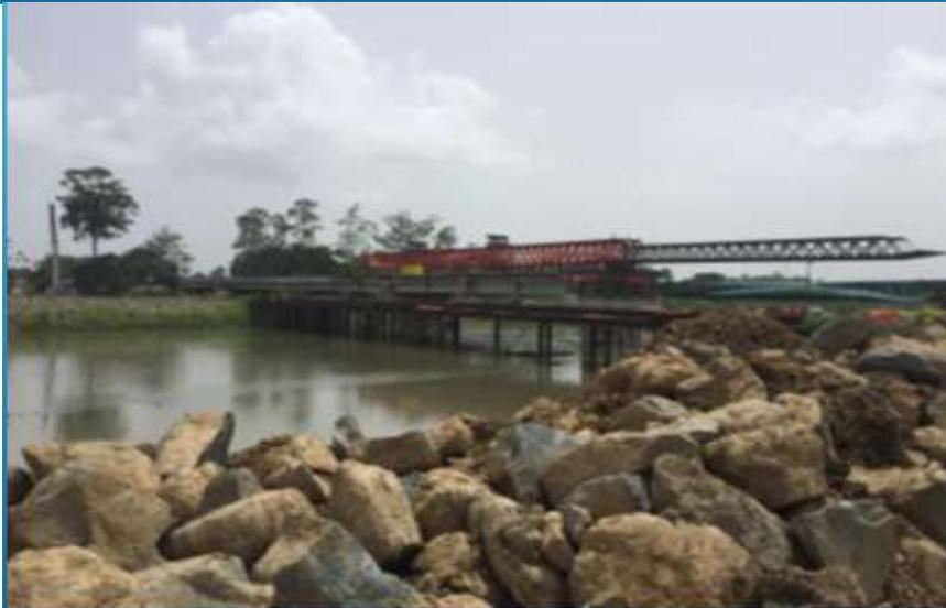
Movilización de lanzadora de vigas sobre el vano 5. Vista Sur – Norte. . Fuente: UNOPS
