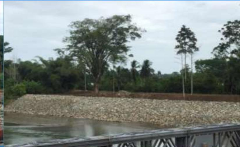
Construcción de enrocado en la margen panameña, aguas abajo. Fuente: UNOPS.
