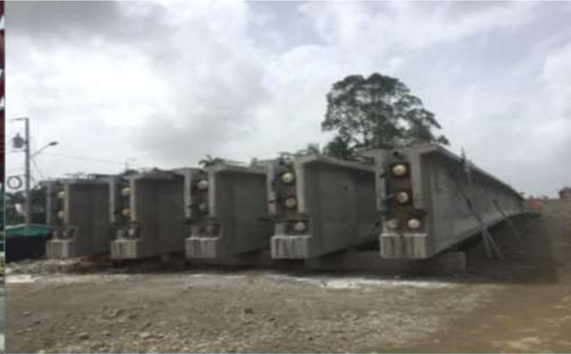
Vigas unidas, tensadas e inyectadas del vano 5. Vista Norte – Sur. Fuente: UNOPS.
