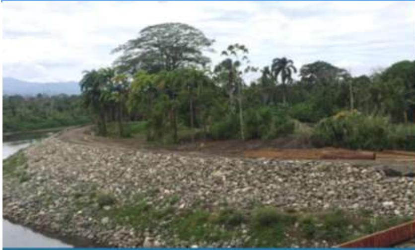
Construcción de enrocado en la margen costarricense, aguas arriba.. Fuente: UNOPS.
