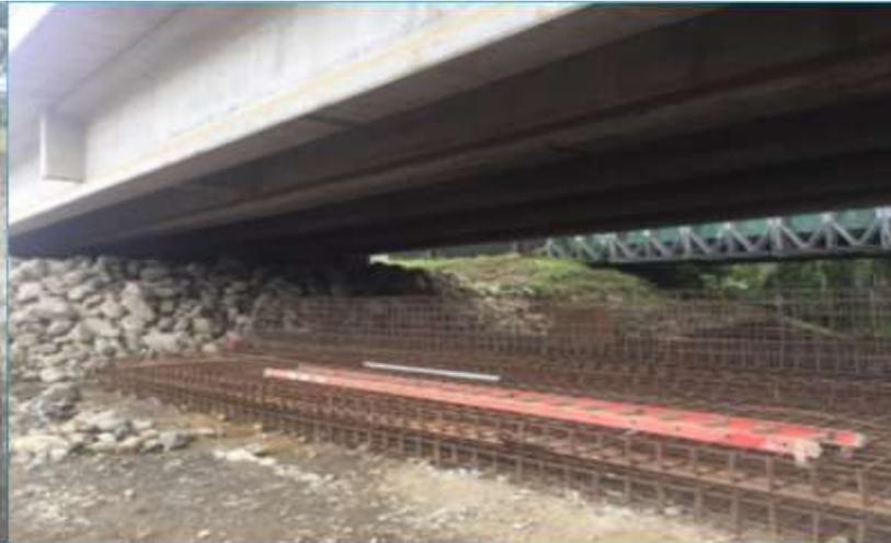
Armadura de losas de aproximación. Fuente: UNOPS.
