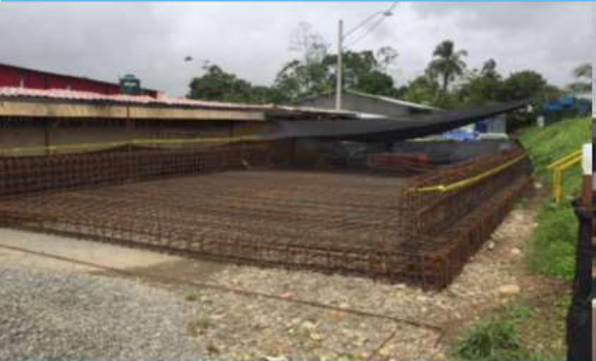
Armadura de cimentación y muretes de paso inferior del lado panameño. Fuente: UNOPS.
