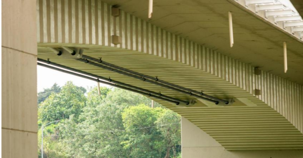
Foto No.8: Finalización y estado de postensados en superestructura de puente.
