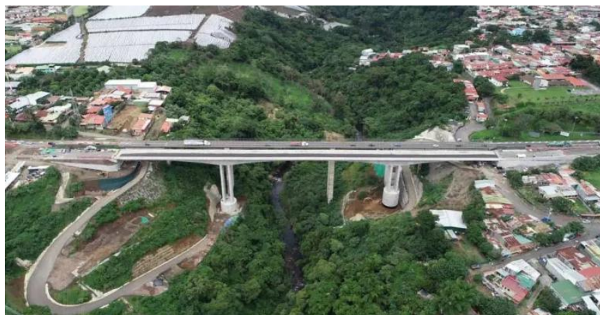
Foto No.6: Vista del puente "Ricardo Saprissa Aymá sobre el río Virilla en la RN No 32.
