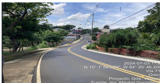
Foto No 13: Diseño y construcción de estructura de drenaje mayor sobre Quebrada Valverde, Ruta Nacional No. 717
