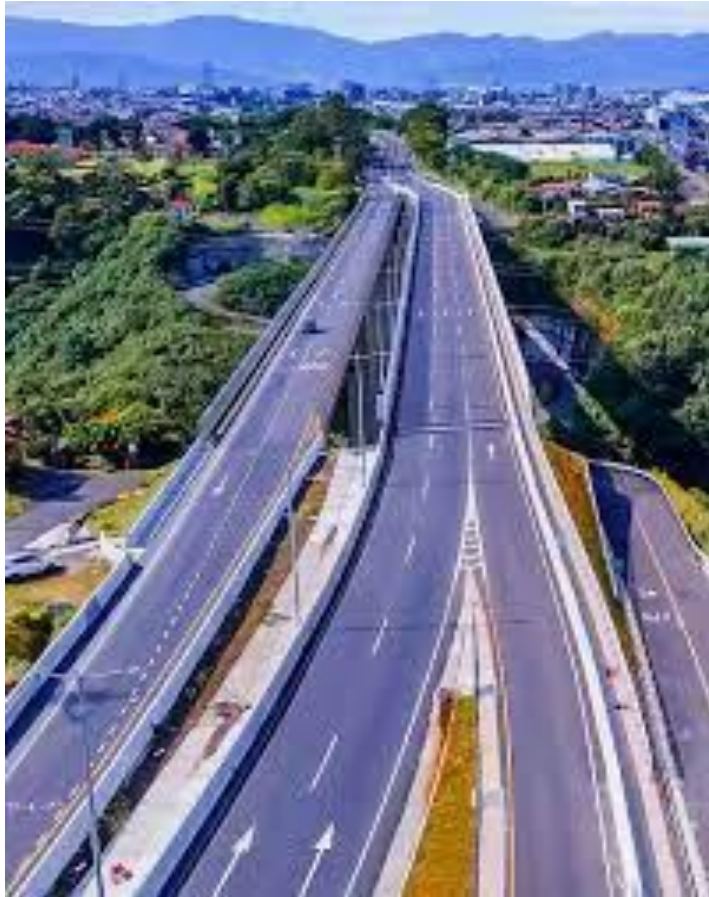
Foto No.7: Vista del puente "Ricardo Saprissa Aymá" sobre el río Virilla en la RN No 32.
