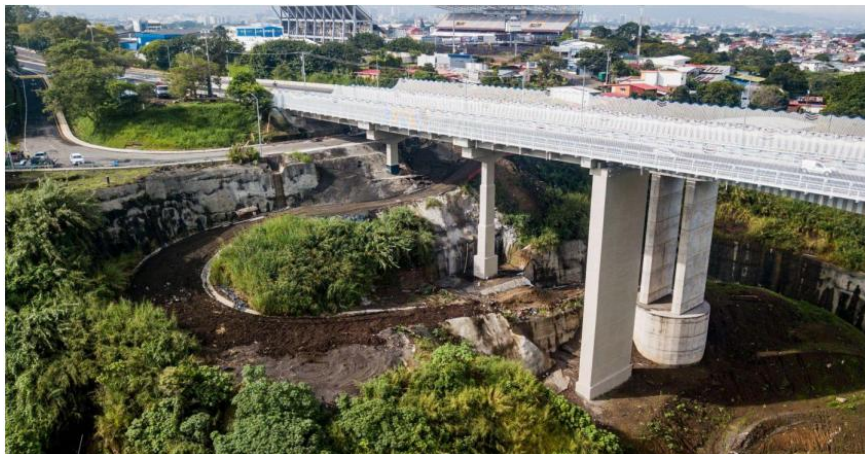
Foto No. 5: Avance en cimentación de pilas 3 y 4.
