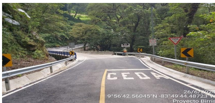
Foto No 14: Diseño y construcción de la Estructura de Drenaje Mayor sobre Río Birris. Ruta Nacional No. 402
