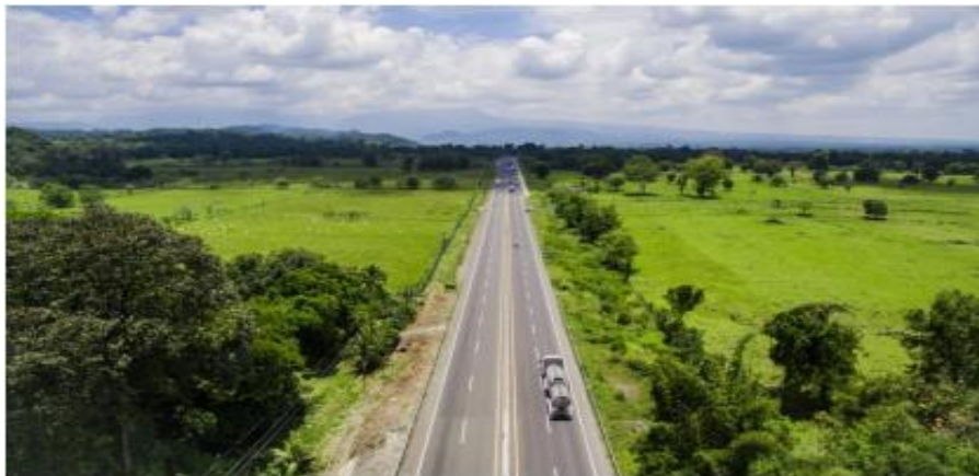
Foto No 1: construcción de la vía
