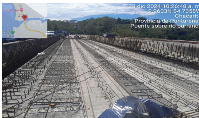
Foto No 15: Rehabilitación del Puente s/el Río Barranca, en la RN No23
