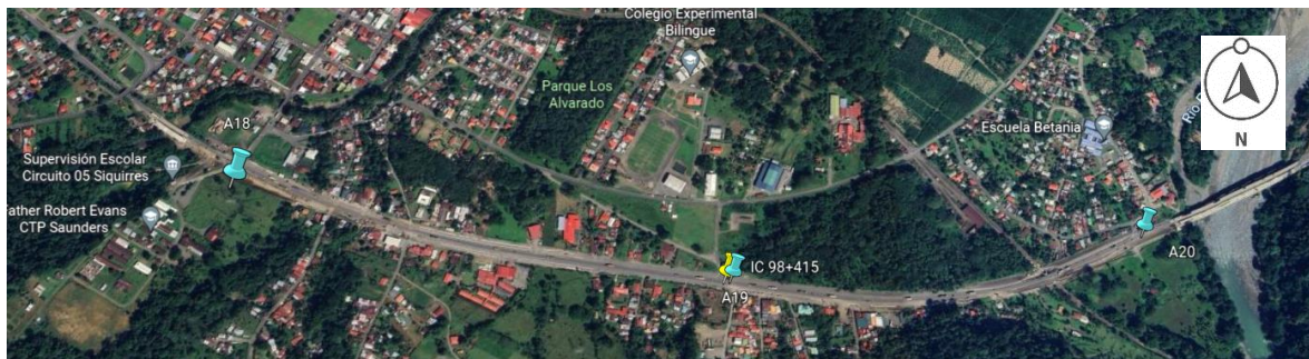
Figura 35. Intersecciones aforadas – IC 98+415
