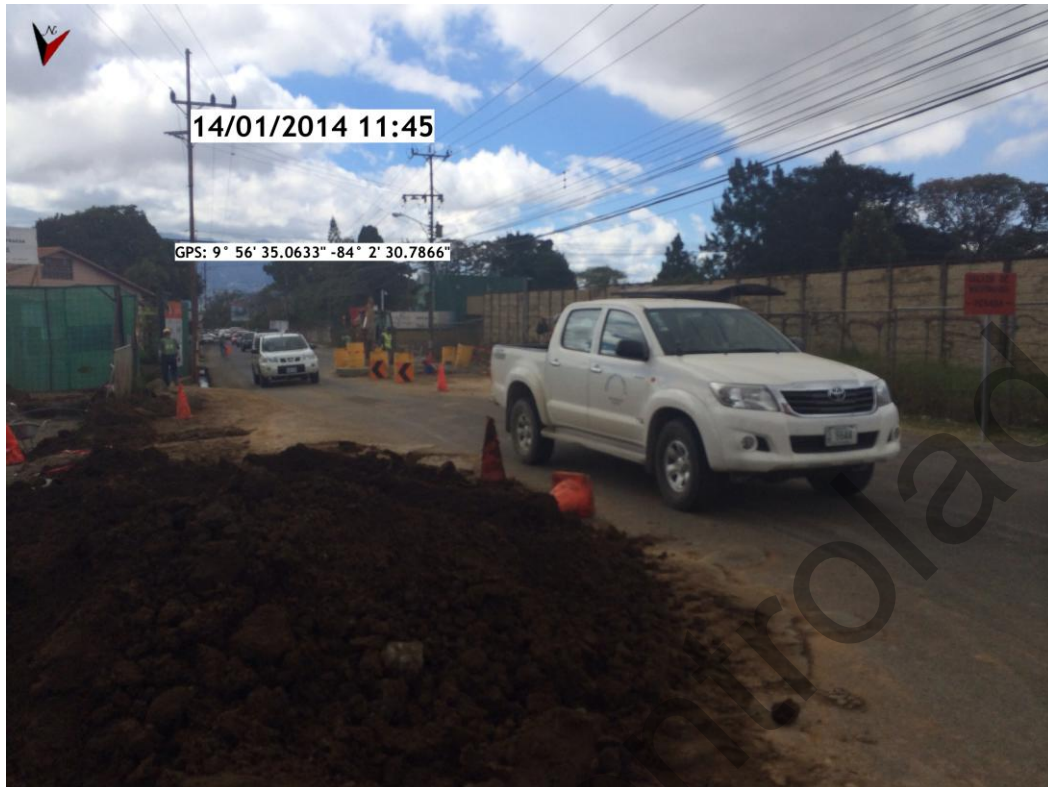
Fotografía 3: Ejecución de obras complementarias por parte de la empresa privada.
