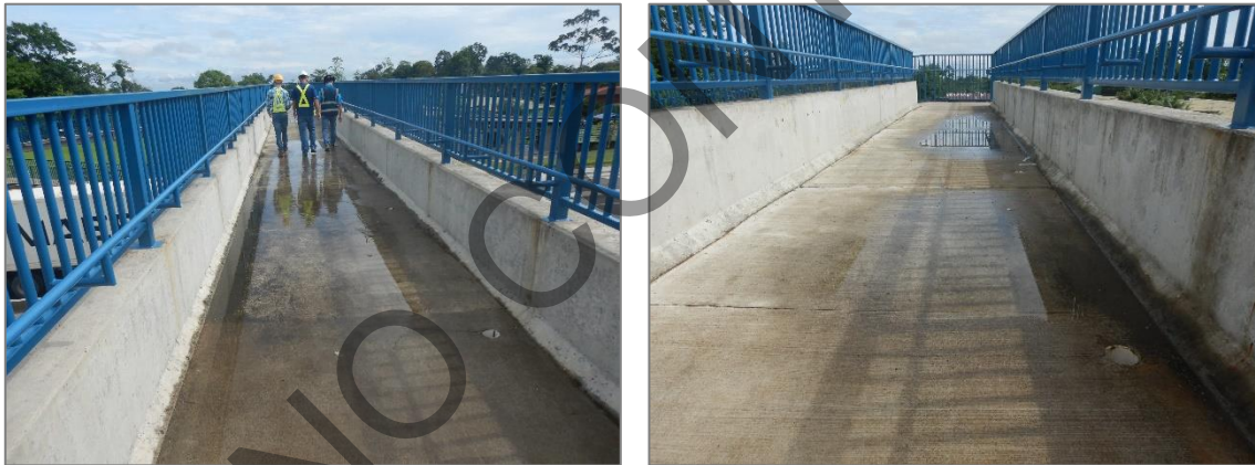
Figura 3. Paso Peatonal La Marina, problemas de empozamiento de aguas en el tablero principal.
