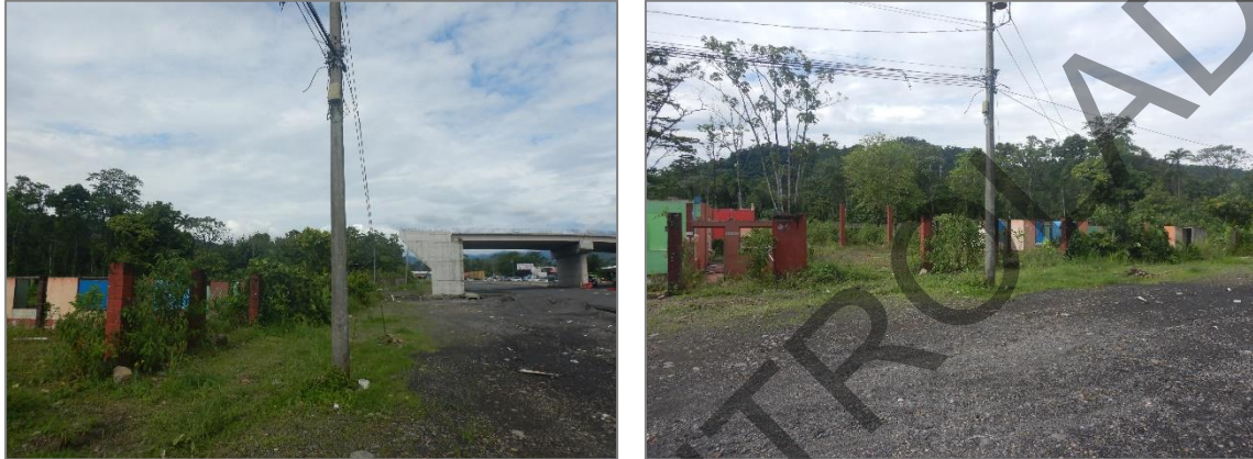
Figura 1. Propiedades por demoler en sitio de Intercambio Cruce Río Frío.
