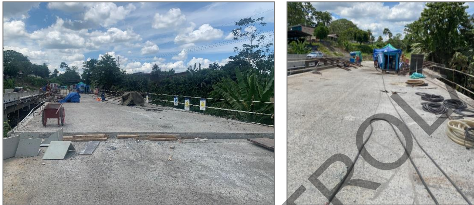
Figura 13. Obras de rehabilitación en el puente existente sobre el Río Siquirres.
