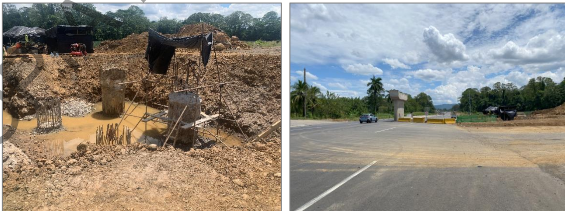
Figura 11. Obras en subestructura del PSV de la Francia.
