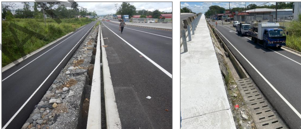
Figura 8. Protección de muro de gaviones con colocación de mortero producto de la colocación de postes para sistemas de contención vehicular.
