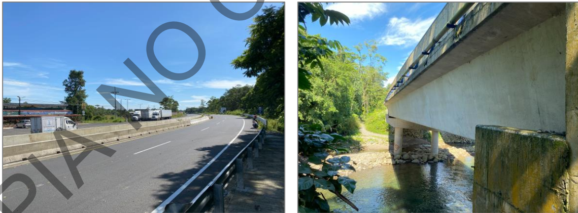
Figura 3. Puente sobre el río Corinto concluido.
