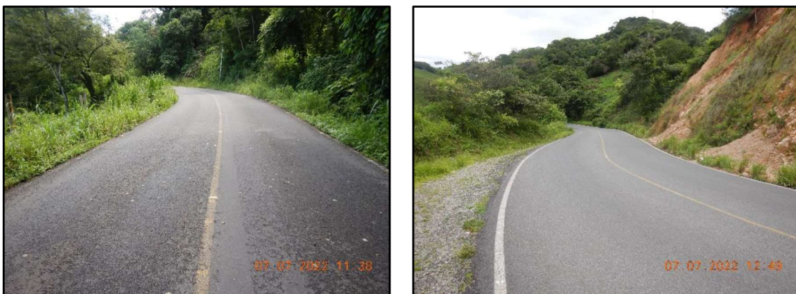
Figura 2. Secciones en buen estado de la superficie de rodamiento de la ruta.
