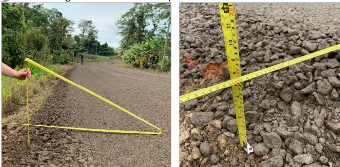
Figura 2. Medición de capa de lastre con cinta métrica.
