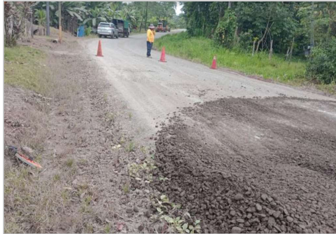
Figura 1. Colocación de material de lastre en Ruta Nacional N°170.
