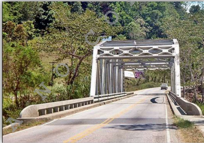
Figura 4. Puente Río Corredores, Ruta Nacional 2. Fuente: Google Imágenes, octubre, 2018.
