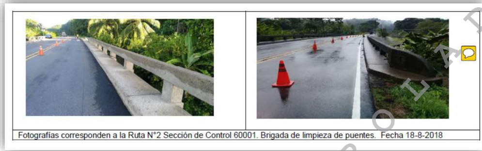
Figura 3. Inconsistencias con fotografías en puentes. Fuente: Informe Zona 4-3, agosto 2018.
