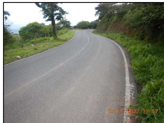
Figura 2. Estado de bueno a regular de la superficie de rodamiento.
