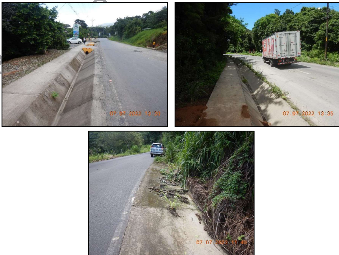
Figura 8. Sistemas de evacuación de aguas (cunetas).
