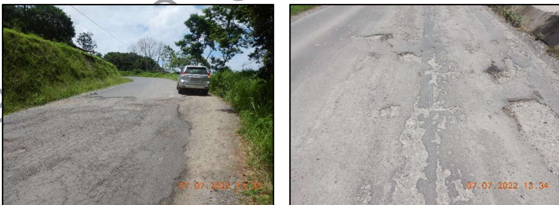
Figura 4. Mal estado de secciones amplias de la superficie de rodamiento de la ruta.
