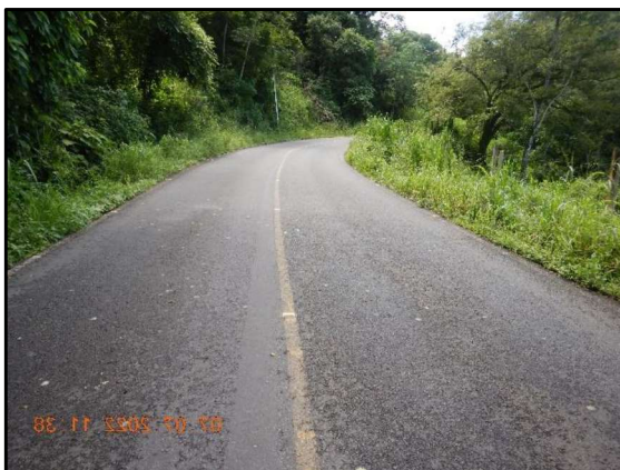
Figura 2. Estado de bueno a regular de la superficie de rodamiento.
