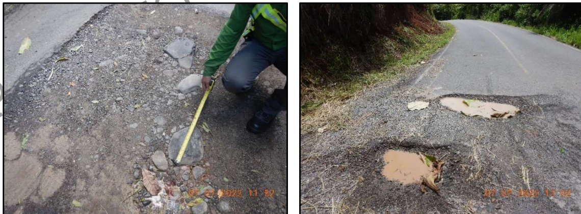
Figura 9. Deterioros con severidad alta y con material granular expuesto y sobre tamaños.
