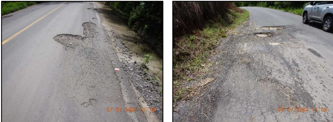
Figura 4. Mal estado de secciones amplias de la superficie de rodamiento de la ruta.
