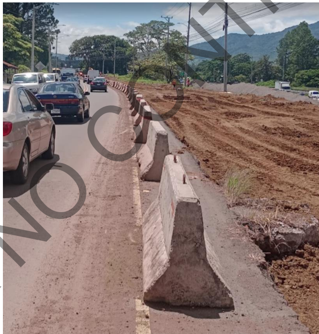
Figura 5. Barreras de canalización sin materiales retroreflectivos.
