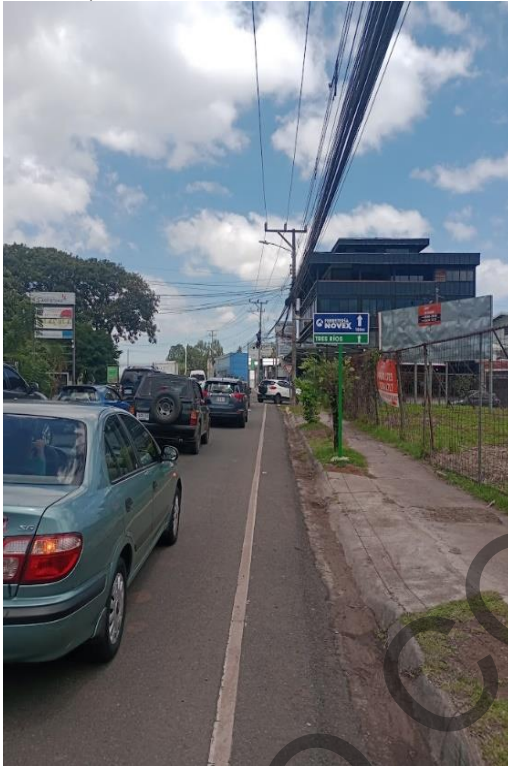
Figura 1. Ausencia señalamiento preventivo antes de obras (RN 251 sentido Tres Ríos-San José).
