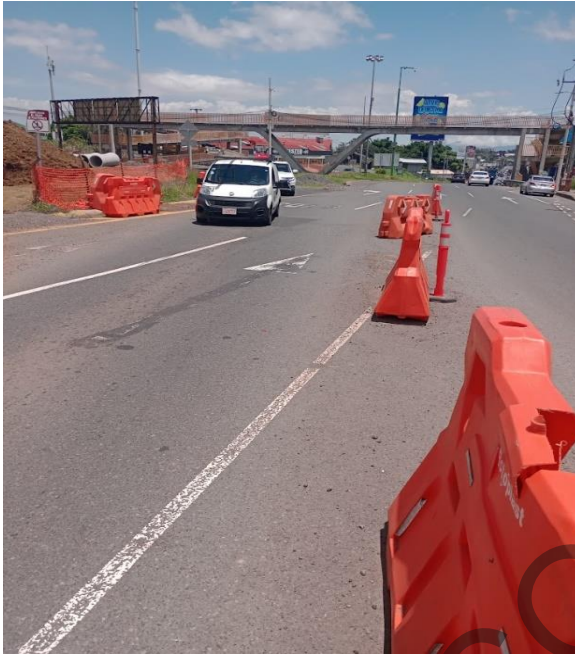
Figuras 11 y 12. Demarcación horizontal parcialmente borrada y sin cambios.
