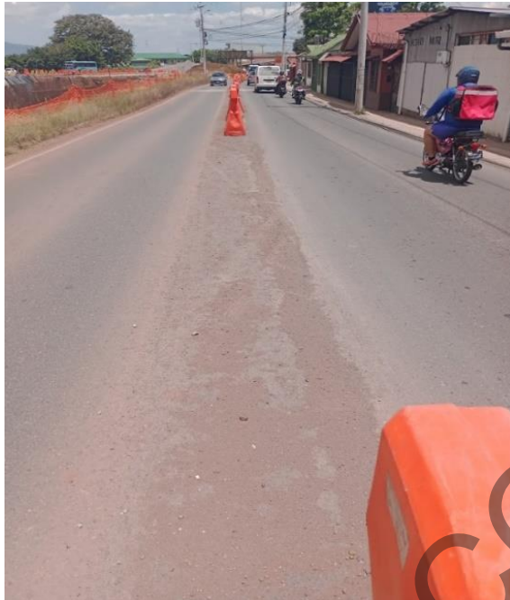
Figura 7. Distanciamiento entre barreras de canalización.
