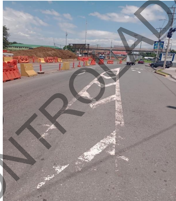
Figuras 11 y 12. Demarcación horizontal parcialmente borrada y sin cambios.
