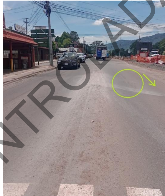
Figura 8. Tramo con dos sentidos de circulación sin barrera de canalización.
