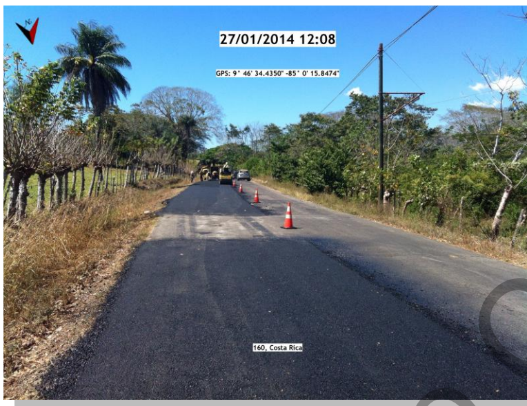
Ubicación por GPS del frente de trabajo
