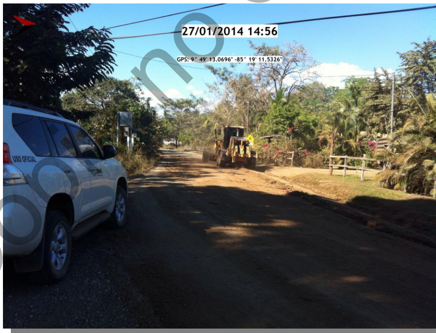
Fotografía con ubicación GPS: Ruta Nacional 160
