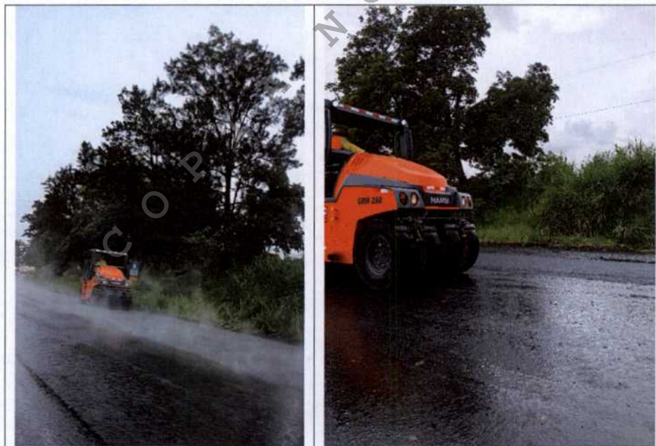
Figura 2: Fotografías del proceso de colocación de mezcla asfáltica. Fuente: Auditoría, agosto 2018.
