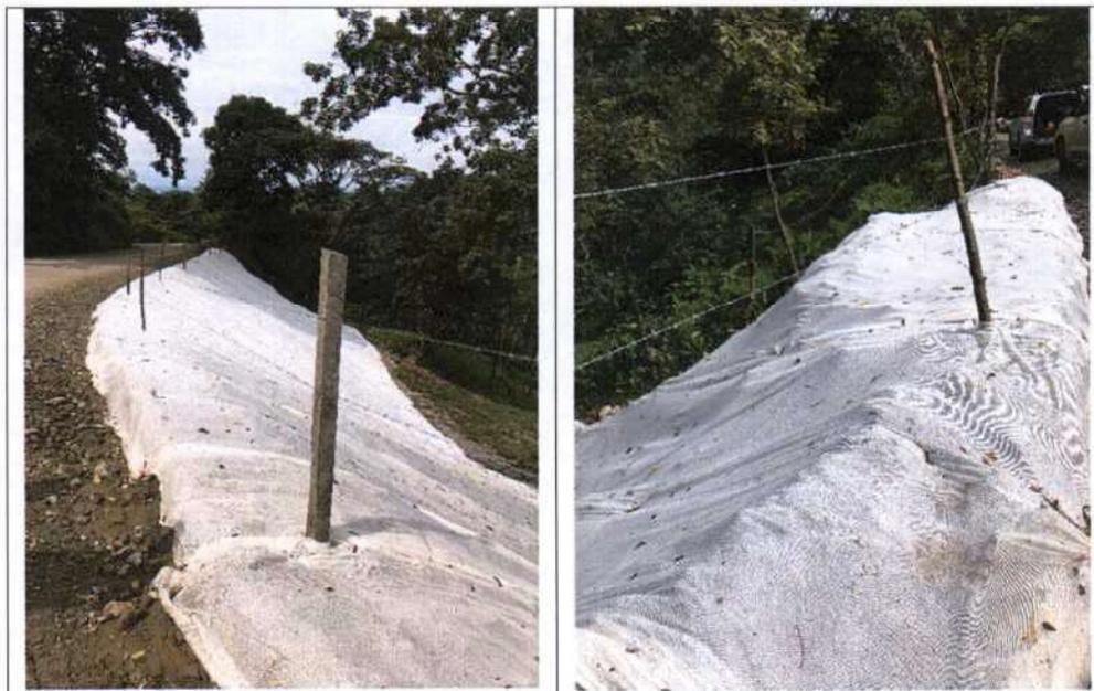
Figura 2: Fotografías de los trabajos de conformación y protección de talud. Fuente: Auditoría, julio 2018.
