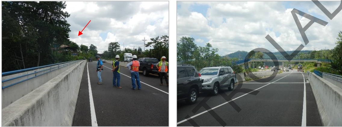
Figura 9. Puente sobre el Río Siquirres: Obra nueva casi en un 100% de avance, pendiente rehabilitación del puente existente por falta de terreno a expropiar.
