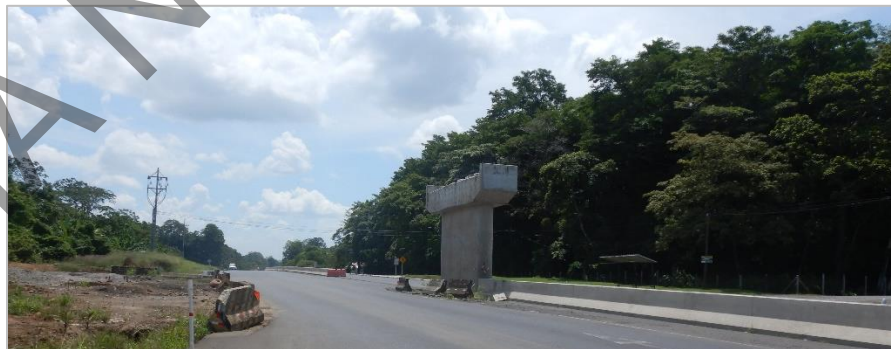
Figura 6. PSV La Francia: Ejecución de la pila principal.
