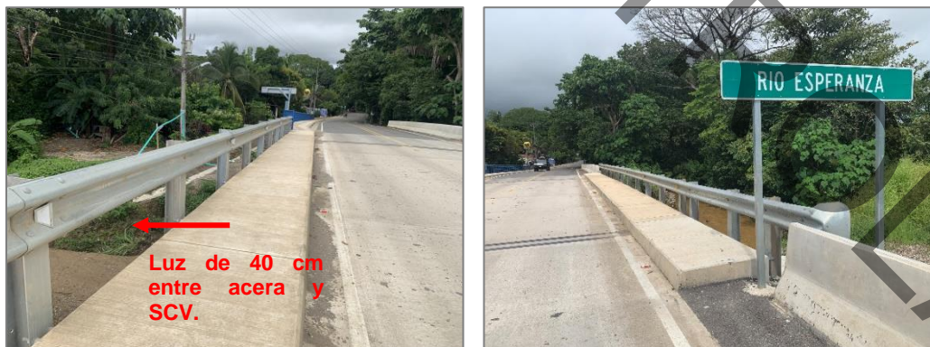
Figura 1. SCV sobre el puente Río Esperanza.
