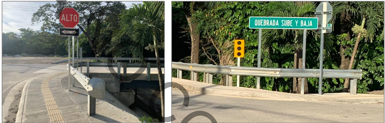
Figura 8. Terminal en ramal de salida en el poblado de Nosara.
