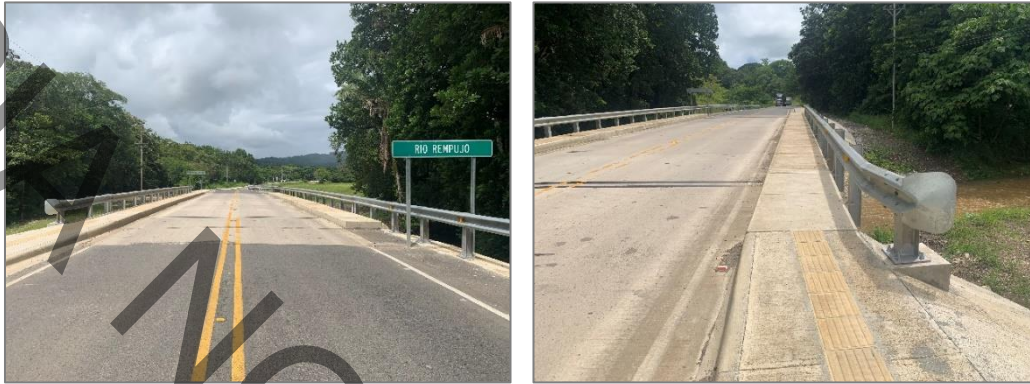
Figura 2. SCV sobre el puente Río Rempujo.
