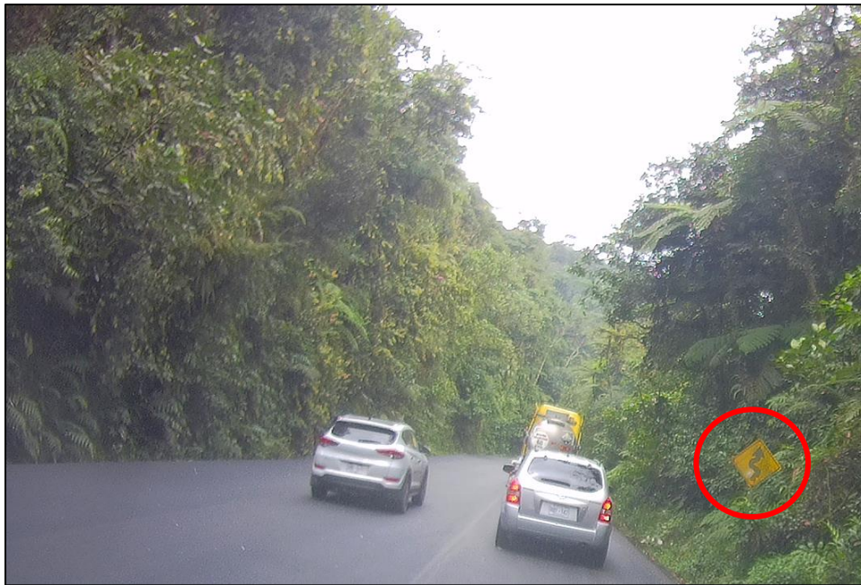
Figura 4. Maniobra de adelantamiento inseguro sobre el tramo de las obras de rehabilitación en el sector Zurquí. Además, se observa una señal que indica aproximación a una zona sinuosa o de curvas.
