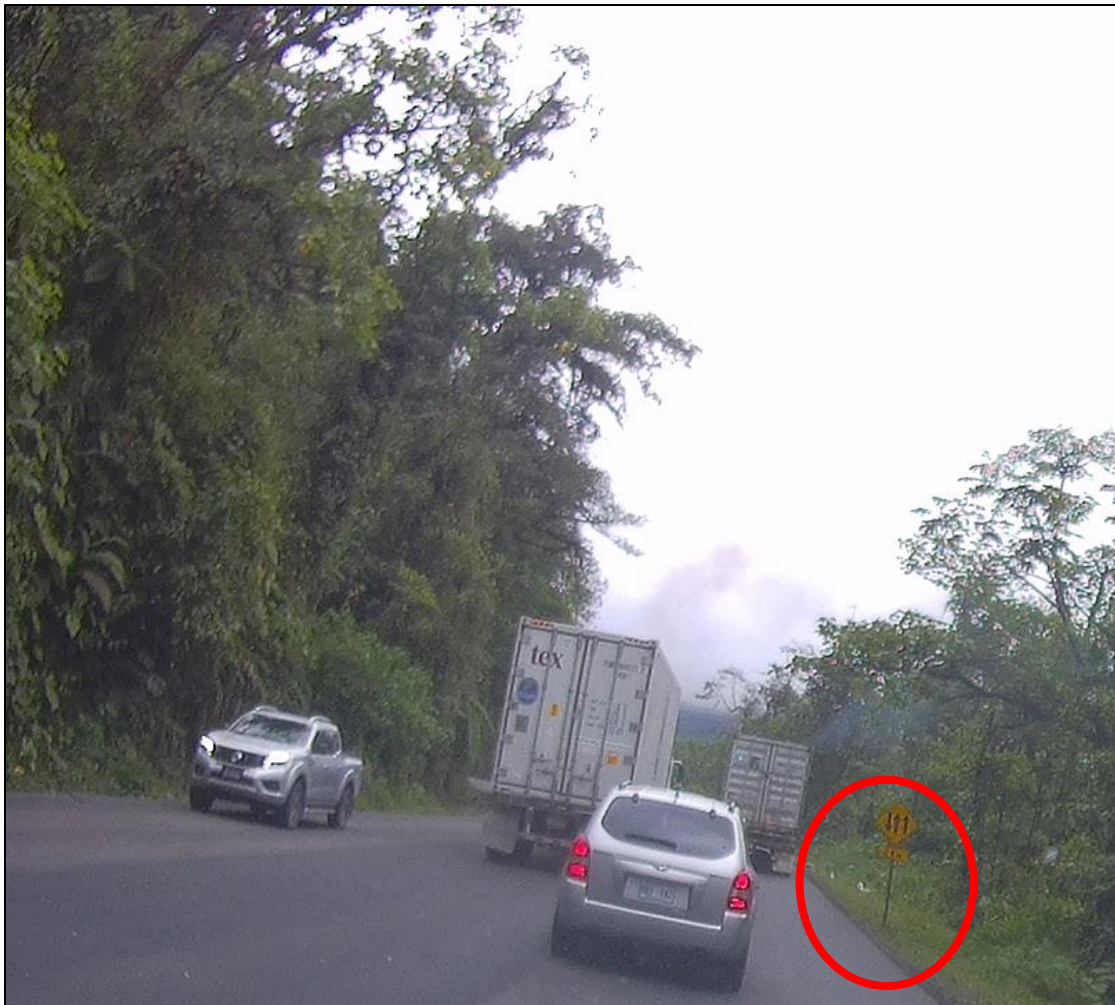
Figura 3. Señalamiento vertical que permite adelantamiento en un sentido de circulación, pero en sentido contrario no existe restricción alguna debido a la ausencia de demarcación.
