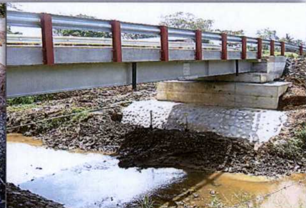
Imagen. Puente construido 2016
