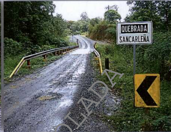
Imagen. Puente construido 2014
