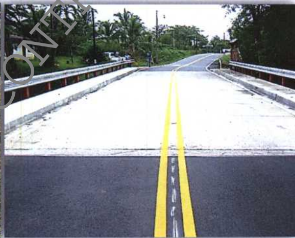
Imagen. Puente construido 2015
