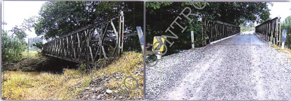
Imágenes. Vistas del estado del puente Bailey existente
