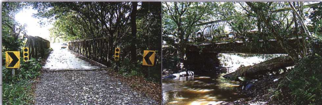
Imágenes. Vistas del puente Bailey existente en el sitio
