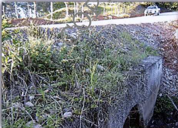
Imagen. Alcantarilla anterior
