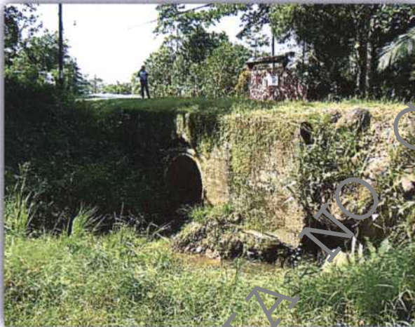
Imagen. Alcantarilla anterior
