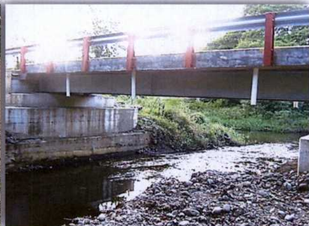
Imagen. Puente construido 2014
