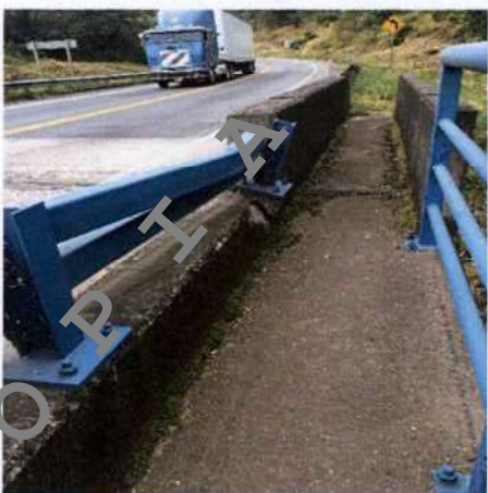
Figura 2. Deformaciones permanentes en sección metálica y desprendimientos y acero expuesto en parapeto de concreto. Fuente: Auditoría – CONAVI, noviembre 2017.
