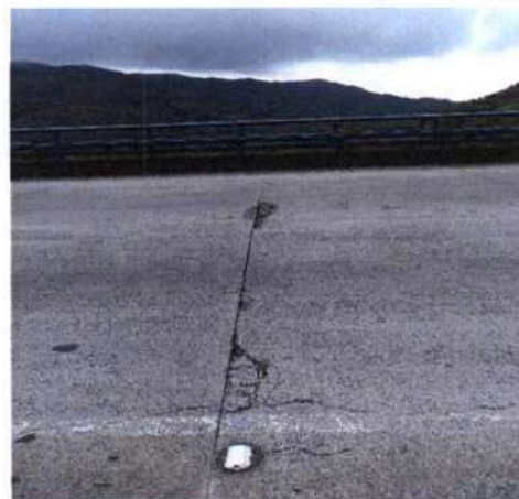
Figura 3. Deterioro y desprendimiento de concreto en las juntas de construcción de la losa superior.
