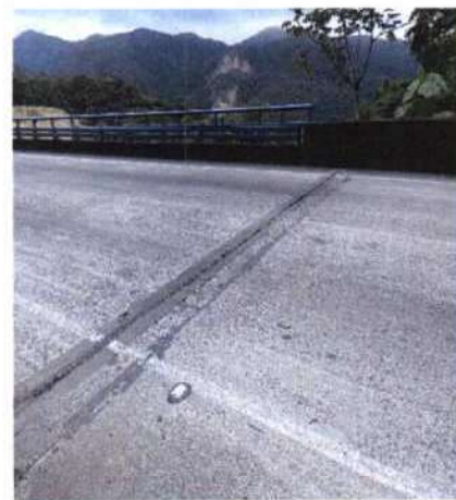
Figura 6. Junta de expansión 2 con desprendimientos de material cementicio en los bordes y agrietamientos del sello. Fuente: Auditoria Conavi, noviembre 2017.
