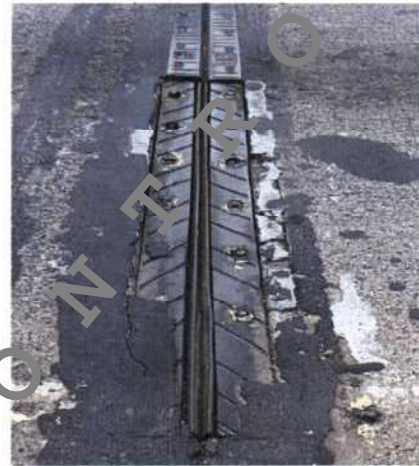
Figura 5. Junta de expansión 1 discontinua, compuesta de tres secciones diferentes y filtración de agua hacia el bastión 1. Fuente: Auditoria-Conavi, noviembre 2017.
