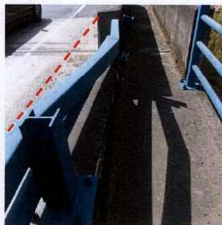
Figura 2. Deformaciones permanentes en sección metálica y desprendimientos y acero expuesto en parapeto de concreto. Fuente: Auditoría – CONAVI, noviembre 2017.
