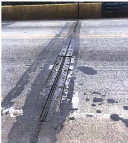
Figura 5. Junta de expansión 1 discontinua, compuesta de tres secciones diferentes y filtración de agua hacia el bastión 1. Fuente: Auditoria-Conavi, noviembre 2017.
