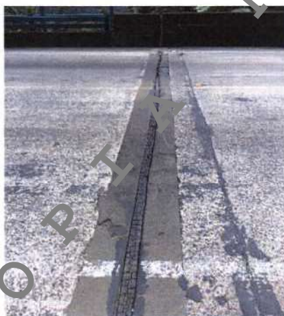
Figura 6. Junta de expansión 2 con desprendimientos de material cementicio en los bordes y agrietamientos del sello. Fuente: Auditoria Conavi, noviembre 2017.
