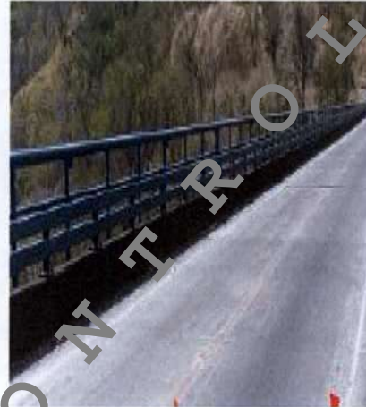
Figura 6. Demarcación borrosa en mal estado en todo el claro del Puente. Fuente: Auditoría CONAVI, noviembre 2017.
