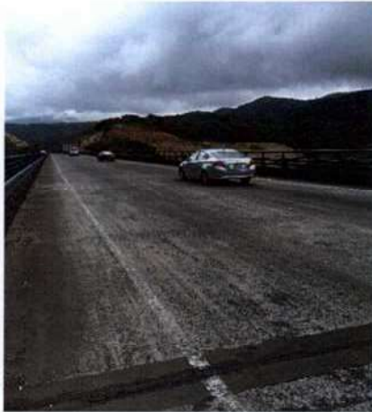
Figura 6. Demarcación borrosa en mal estado en todo el claro del Puente. Fuente: Auditoría CONAVI, noviembre 2017.
