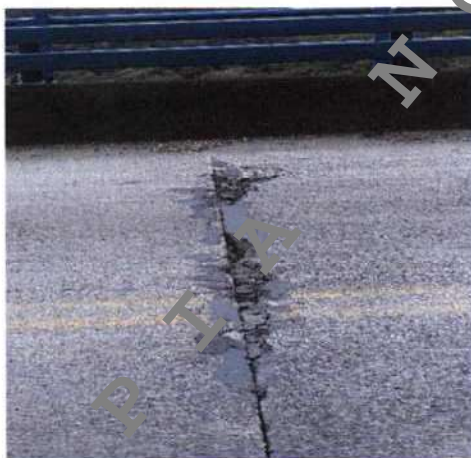
Figura 3. Deterioro y desprendimiento de concreto en las juntas de construcción de la losa superior.
